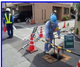
断・通水作業
