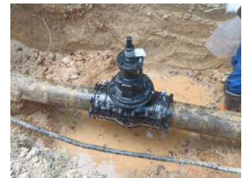
緊急不断水工事
