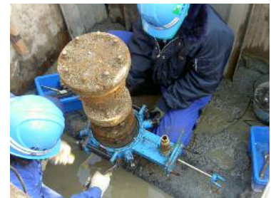
補修弁取替工法
