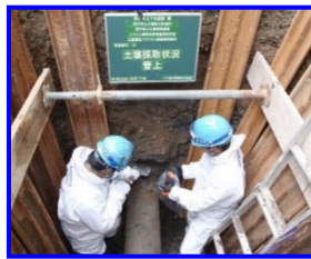
埋設環境調査
