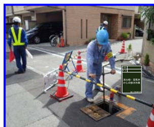
断・通水作業
