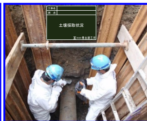
埋設環境調査
