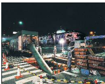
管更生工事（パルテムHL工法）
