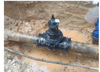
緊急不断水工事
