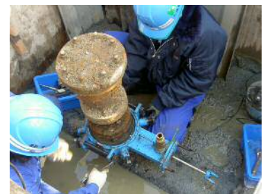
補修弁取替工法
