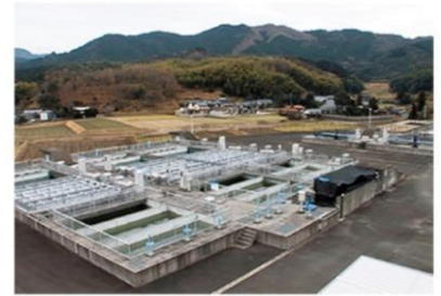
T水道事業団 (14,700m 3 /日、凝集・沈澱・砂ろ過・活性炭)
