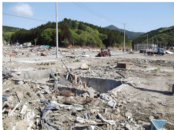
清水第二ポンプ場 津波により全壊流出
