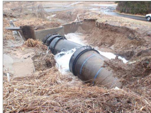
伸縮可とう管の抜け出しによる漏水発生
