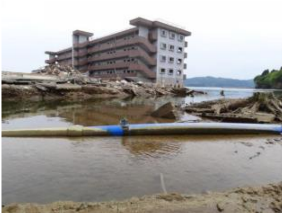
道路が流失し、露出した管
