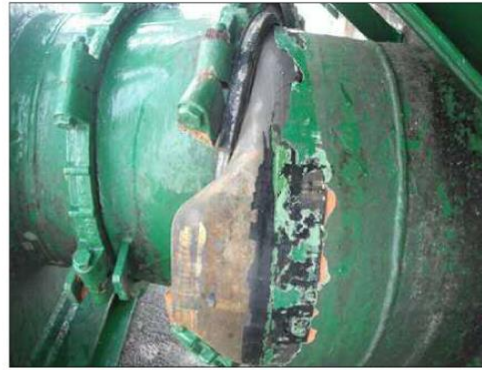
伸縮管の破断による漏水発生
