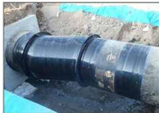
鋼管溶接による復旧
