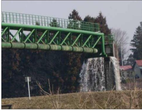
伸縮管の破断による漏水発生
