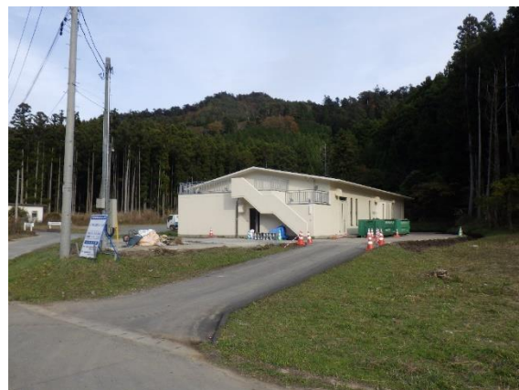
復旧中 (大浜ポンプ場 令和 4 年 2 月竣工)
