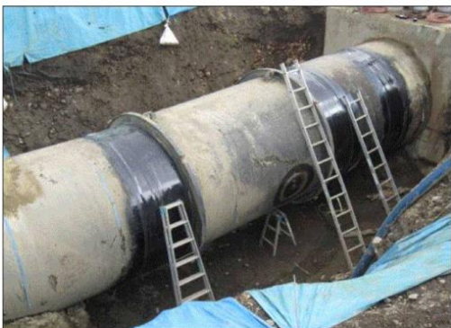
鋼管溶接による復旧
