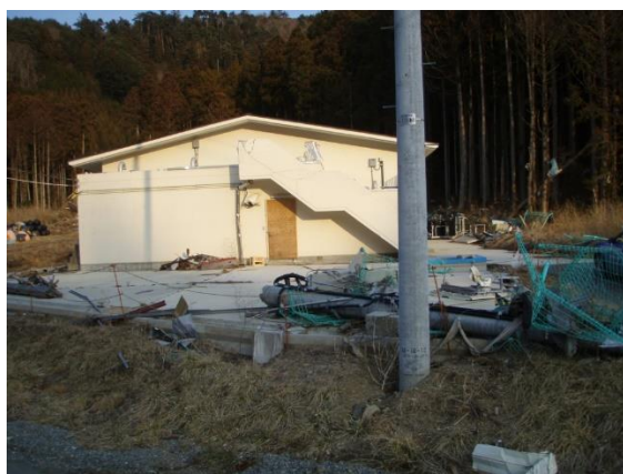
大浜浄水場 被災復旧前
