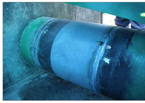
鋼管溶接による復旧
