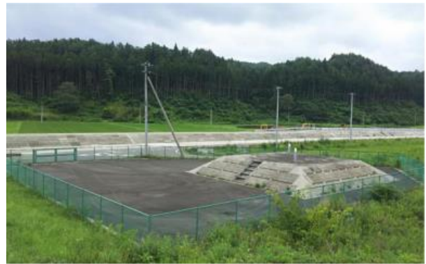
津波対策で張ブロックを施した水源
