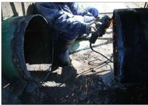
既設管一部撤去
