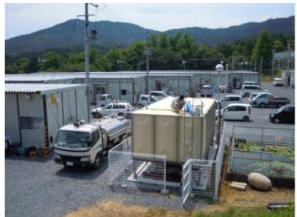
仮設住宅完成後も水道が未復旧の状態
