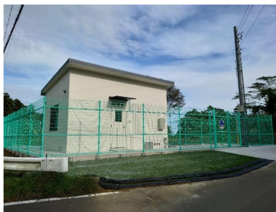
復旧後（相川送水ポンプ場）
