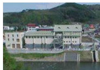
N市浄水場
