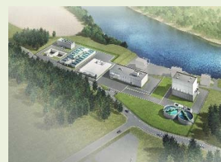
第一北上中部工業用水道 浄水場建設事業(DB) 浄水場(2.0万 m 3 /日)建設等
