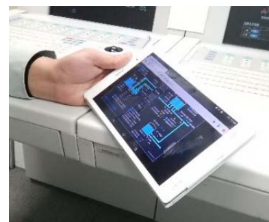
遠方監視システム
