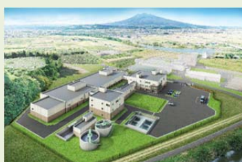
桶の口浄水場等建設事業(DBO) 浄水場(3.8万 m 3 /日)建設等 及び市内 87 か所施設の運転管理
