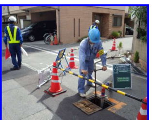
断・通水作業
