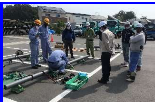
配水場内継手講習会
