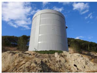
土砂崩れに耐えたPCタンク
