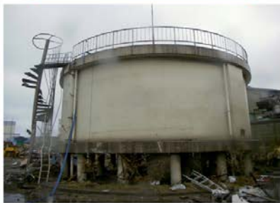
津波に耐えたPCタンク
