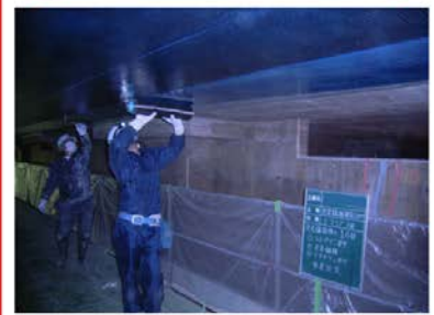
RC配水池の耐震補強事例
