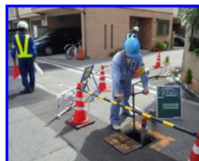
断・通水作業
