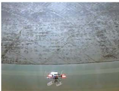
ドローンによる点検例
