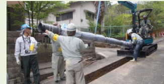
老朽管更新事業
