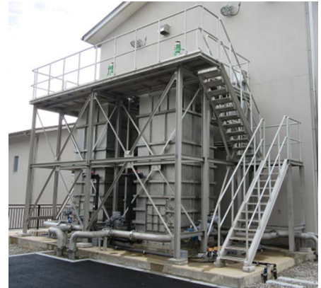
帯磁性イオン交換樹脂 (MIX®) 処理システム
