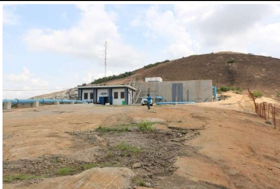
第 5 ポンプ場配水池 (EB5 : 5000m 3 )
