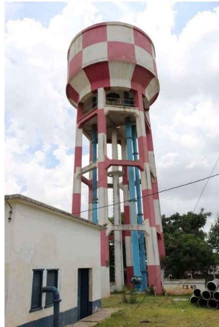
第4 ポンプ場内にある高架タンク
