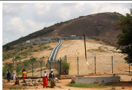
第 5 ポンプ場配水池 (EB5 : 5000m 3 )
