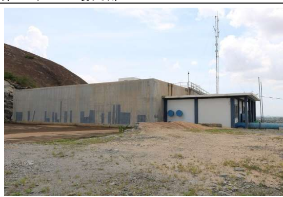
第 5 ポンプ場配水池 (EB5 : 5000m 3 )
