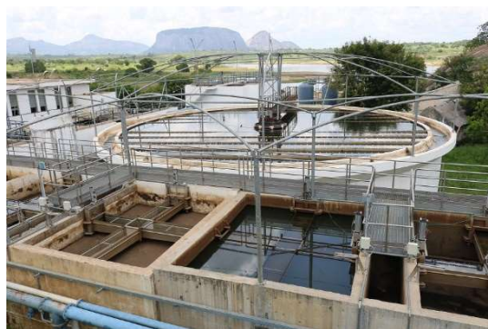
ナンプラダムの浄水場
