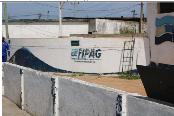
第 3 ポンプ場 (EB3) と貯水池
