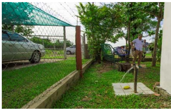
No.8 ビジャ・アジェス市内給水状況調査 管網の末端部地域の水圧状況を確認し、問題がないことがわかった。
