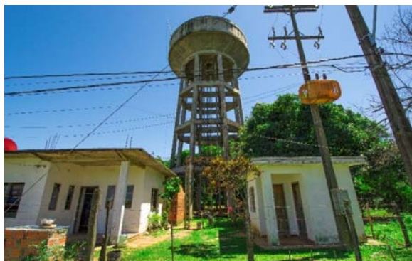
No.9 ベンハミン・アセバル水衛生委員会の高架タンク 水源である井戸に隣接して設置されており、高架水槽を経由した自然流下方式により、配水管網による各戸給水が実施されている。
