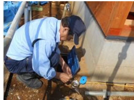
給水装置完了検査
