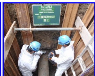
埋設環境調査
