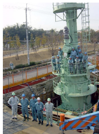
インサートバタフライ弁施工状況
