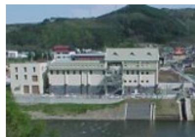
N市浄水場
