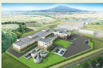
樋の口浄水場等建設事業(DBO) 浄水場(3.8万 m 3 /日)建設等 及び市内 87 か所施設の運転管理
