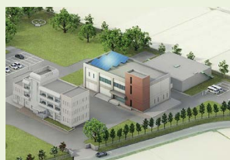
坂根浄水場等建設事業(DBO) 浄水場(1.9万 m 3 /日)建設等 及び市内 79 か所施設の運転管理
