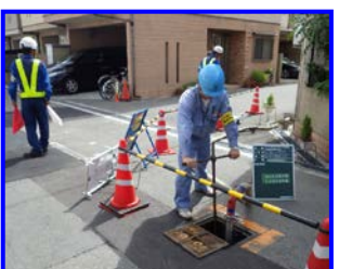
断・通水作業
