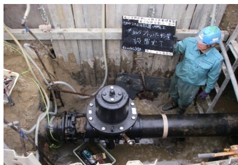
プラグ 3 型施工状況
