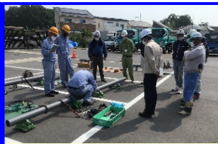
配水場内継手講習会
