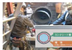
例：管路の耐震補強
