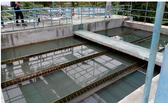
沈殿槽が白濁している
