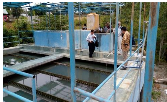
着水井から沈殿槽
