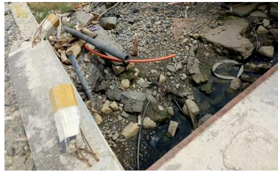
道路橋の床版の移動に伴い破断された配水管(PVC)
