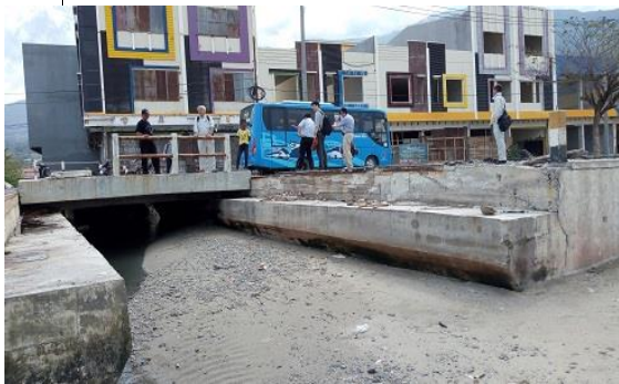
津波により 11m ほど内陸側(写真左手)に移動した道路橋の床版。橋脚からのズレが見える
