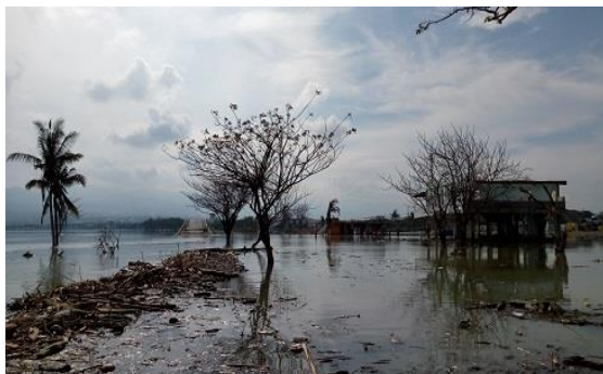
冠水した道路の写真奥に落ちた橋脚が見える
