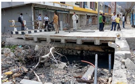
右側に移動した床版と破断された配水管(写真右下)
