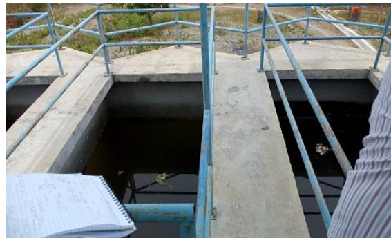
ろ過槽が使われておらず溜池状態となっている
