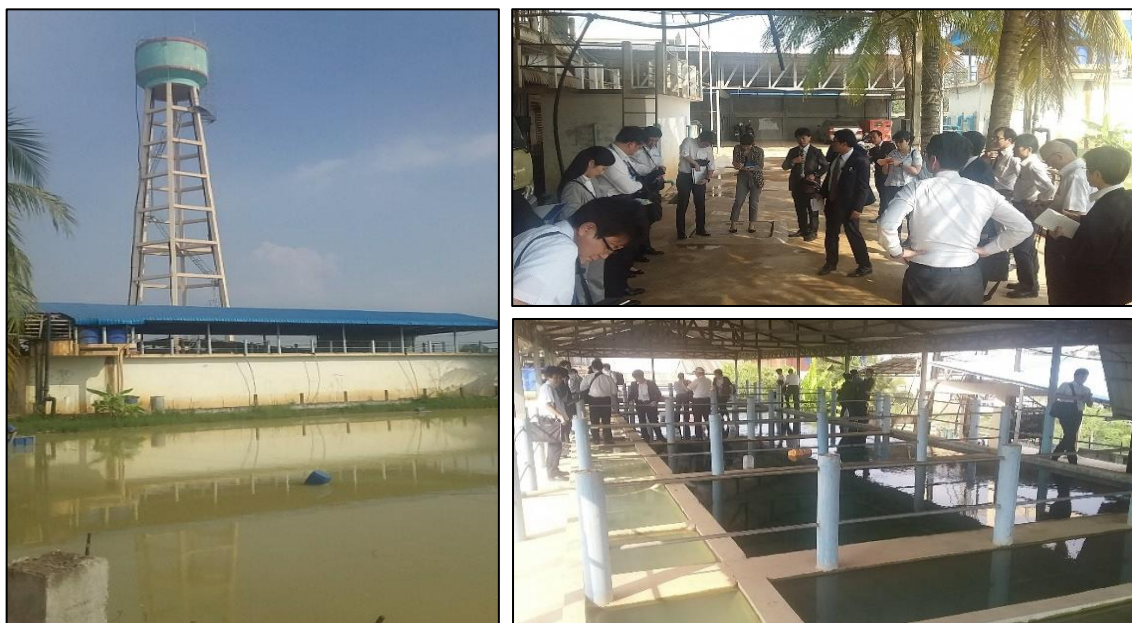
図 2.2 サムロアン・ヨン浄水場(写真)
