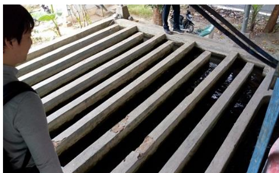
フロック形成槽の構造がフロック形成しにくい
