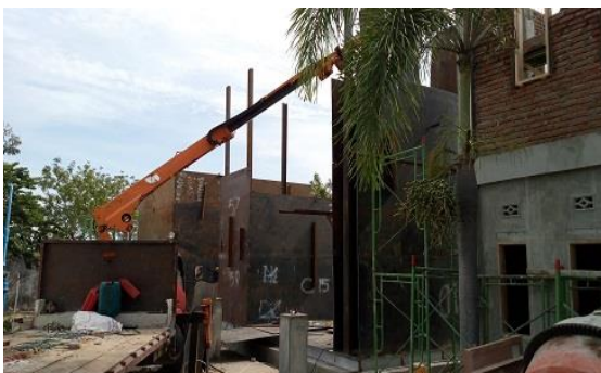
新規建設中の鋼板製凝集沈殿ろ過処理施設(10L/s)
