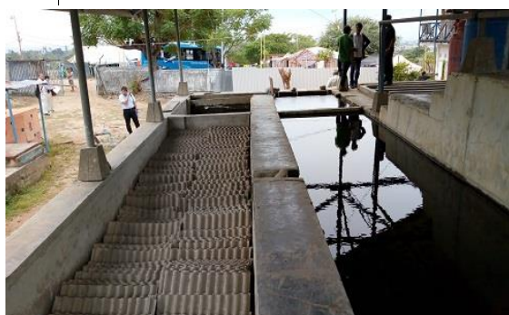
利用されていない系統の沈殿槽
