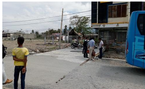
津波により 11m ほど内陸側(写真左手)に移動した道路橋の床版。橋脚からのズレが見える
