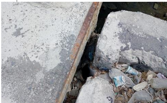
道路橋の床版の移動に伴い破断された配水管(PVC)
