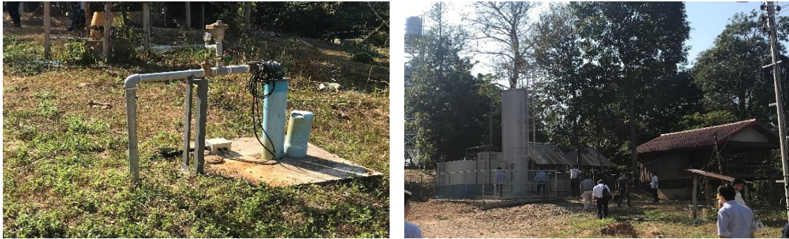
図 3.3 ブンター村浄水場視察の様子
