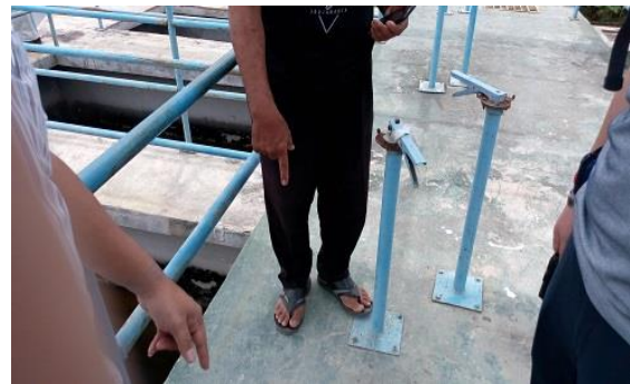
ろ過槽が使われておらず溜池状態となっている
