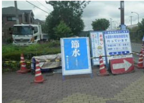
(工事現場：東京都水道局 提供)
