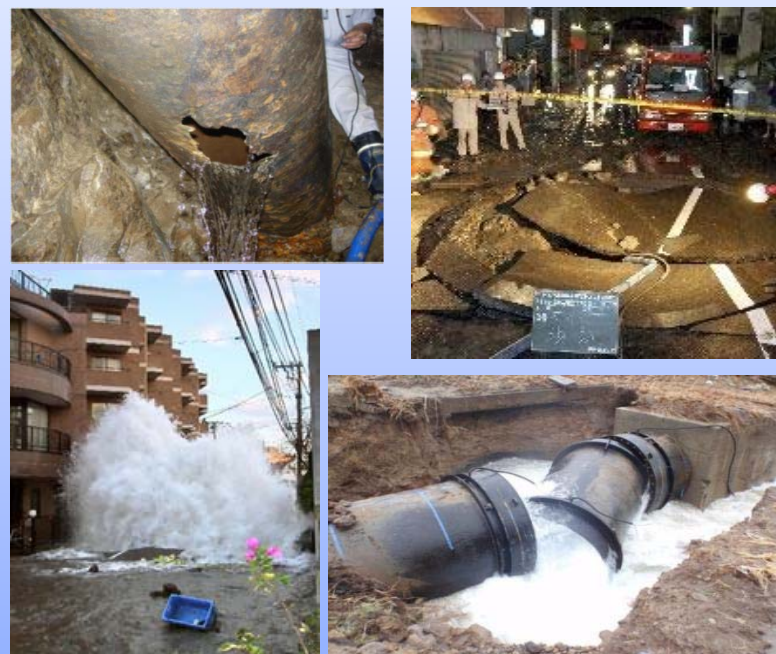
老朽化による事故の例
