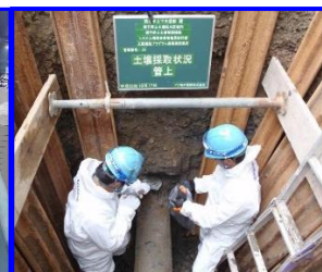
埋設環境調査
