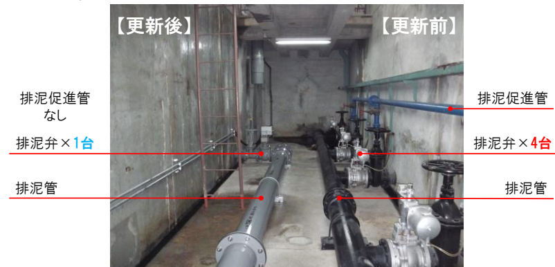
写真 レシプロ式汚泥掻寄機の採用による更新前後の状況（排泥管廊）
