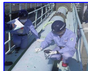
水管橋の点検
