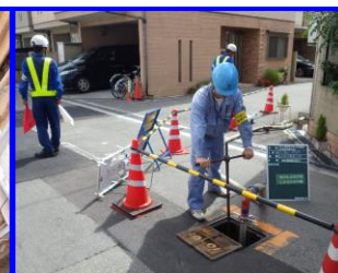
断・通水作業
