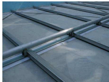
写真 レシプロ汚泥掻寄機（くさび型スクレーパ）
