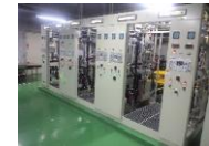
修繕・更新工事
