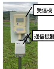
受信機: 水道本体メーターからの情報を表示する機器。留萌市では凍結防止のためメーター本体を目視で確認できない深さに設置していることから受信機を設置し検針。
