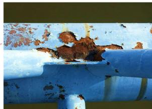
下弦材(部材接合部)の腐食
