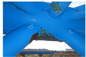
上弦材(部材接合部)の腐食
