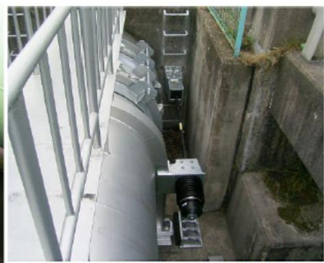
図-7.4.26 伸縮管と移動制限装置
