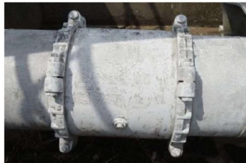
以下の写真は、クローザタイプから水道管が抜け出し方向に移動している様子である。①のスリーブ内に挿入されていた送水管の外面が露出し、その部分が腐食している。このような状態で伸縮が繰り返されると、止水ゴムが劣化し漏水の原因になる。
