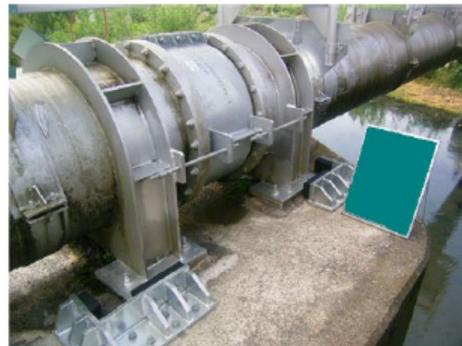
図-7.4.24 橋脚固定端の伸縮管と移動制限(落橋防止装置)
