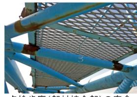
点検歩廊(部材接合部)の腐食
