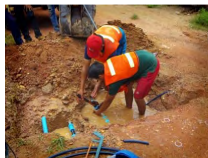
漏水補修作業 (NPNL 提供写真)
