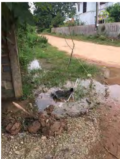
漏水状況 (NPNL 提供写真)
