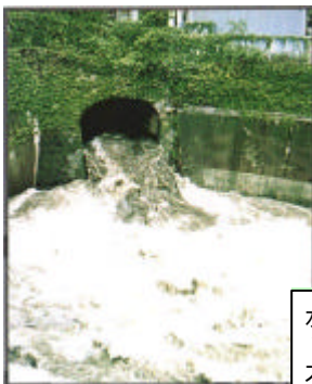
未処理汚水の放流状況
