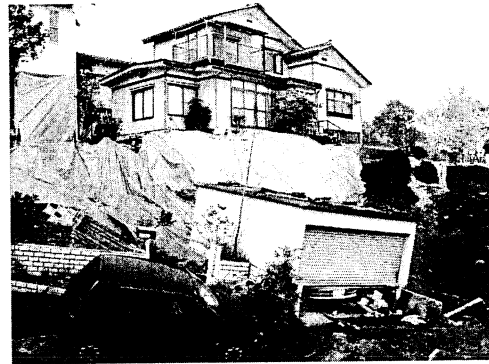
新潟県中越地震による宅地の被害
