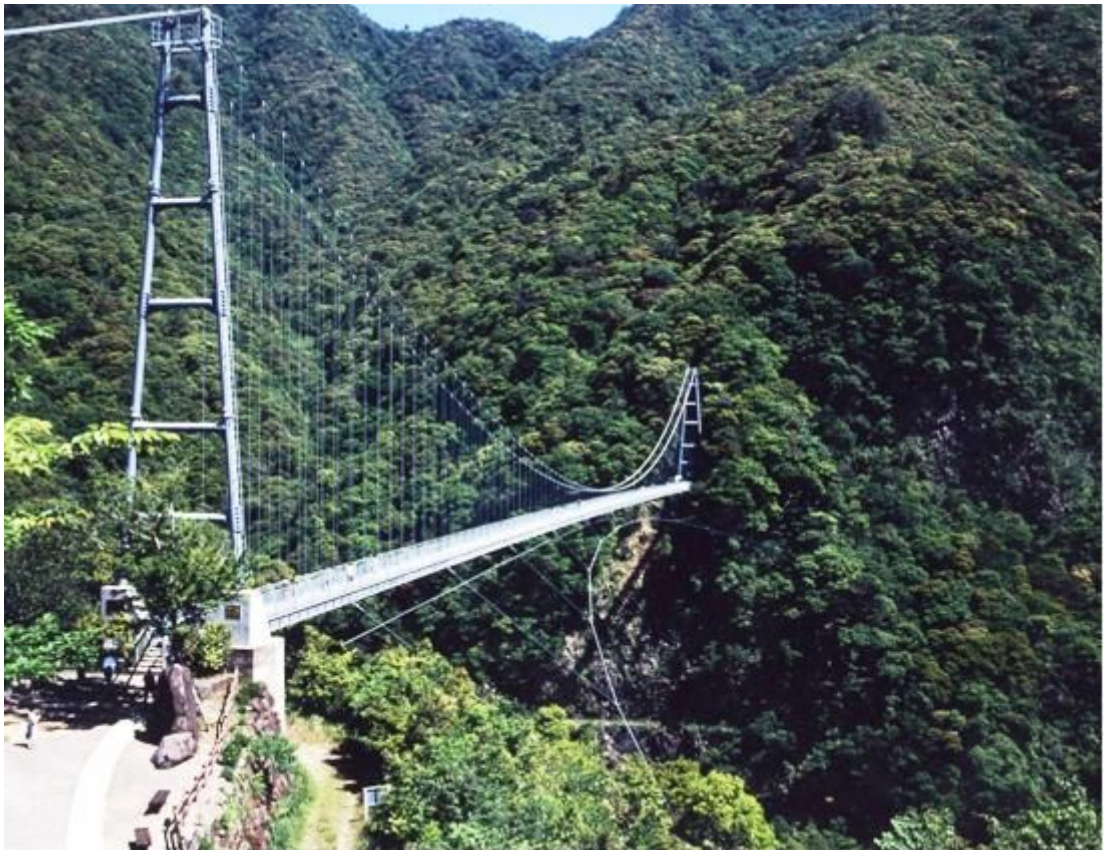
歩いて渡ることができる世界最大級の吊橋「照葉大吊橋」 (資料:綾町提供)
