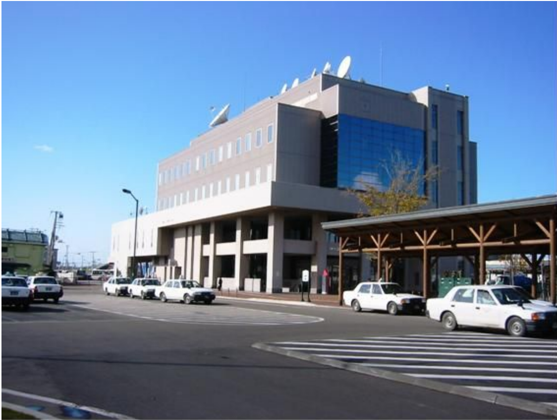
自治体ネットワークセンター
