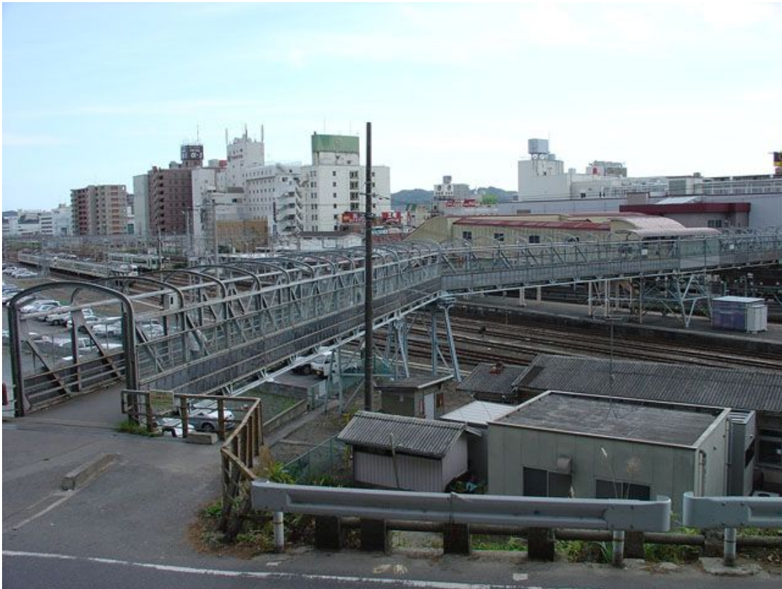
現在の南北通路:平安橋 (写真提供:いわき市)
