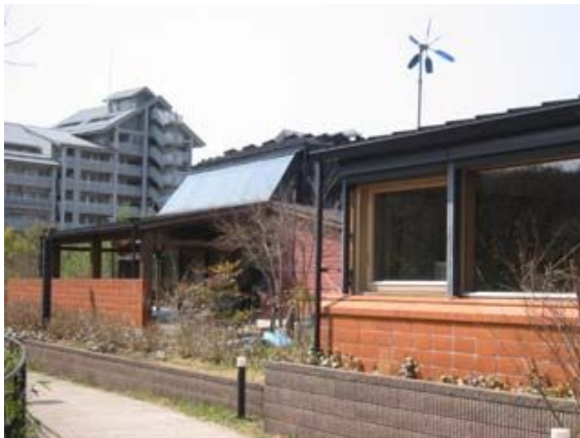
長池ネイチャーセンターの外観
