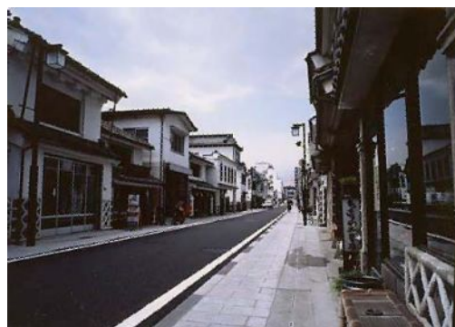
中町通り 電線類地中化
