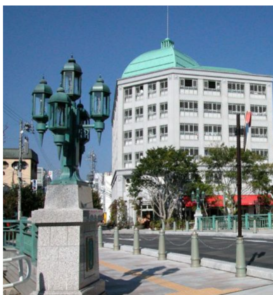
特定公共賃貸住宅外装・一ツ橋歩道橋
