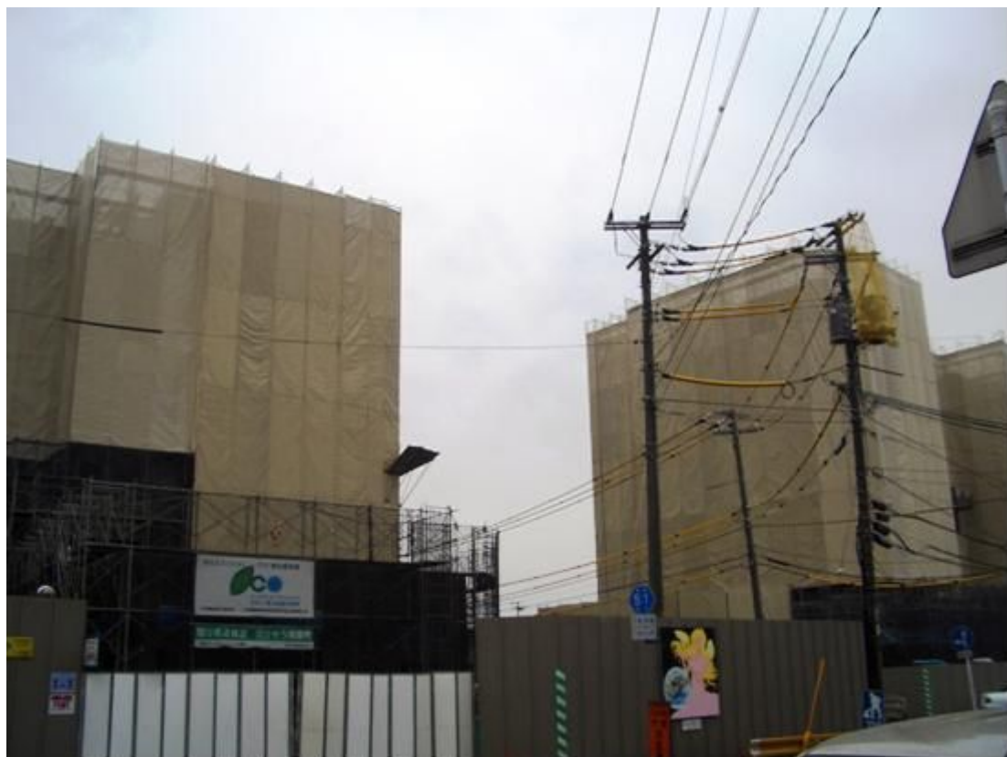
市街地再開発事業(工事中)
