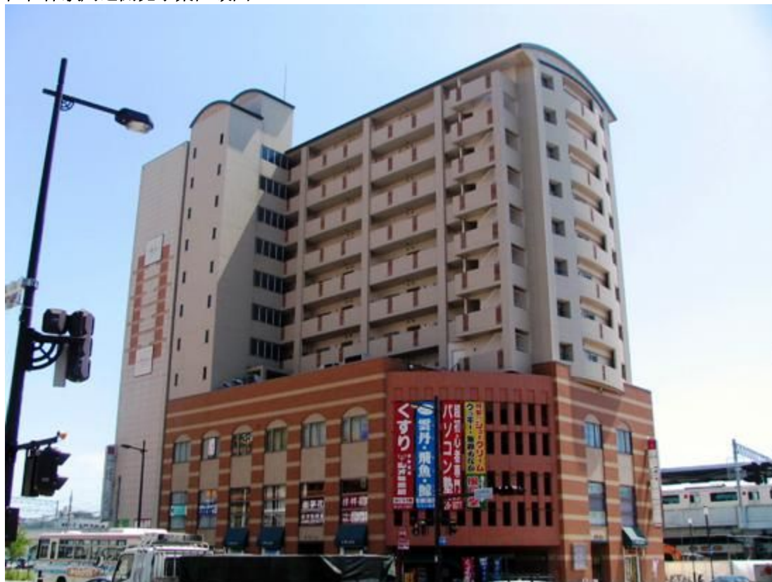
潮見地区市街地再開発事業「エス・プラザ」
