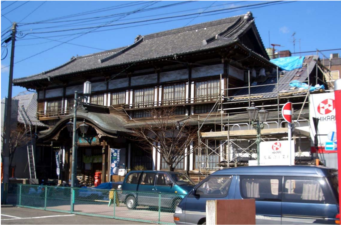
竹瓦温泉(まちづくり交付金で屋根の改修中)
