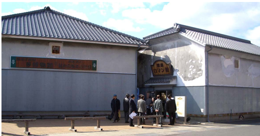
「昭和ロマン蔵」入口
