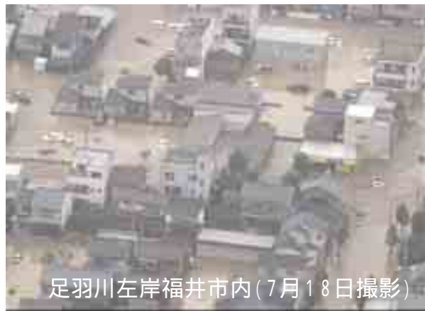
浸水被害状況
