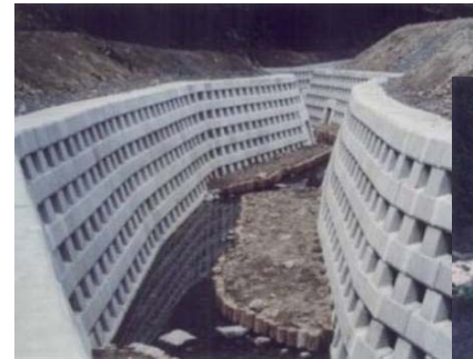
整備直後の旧岩戸川 (平成元年)
