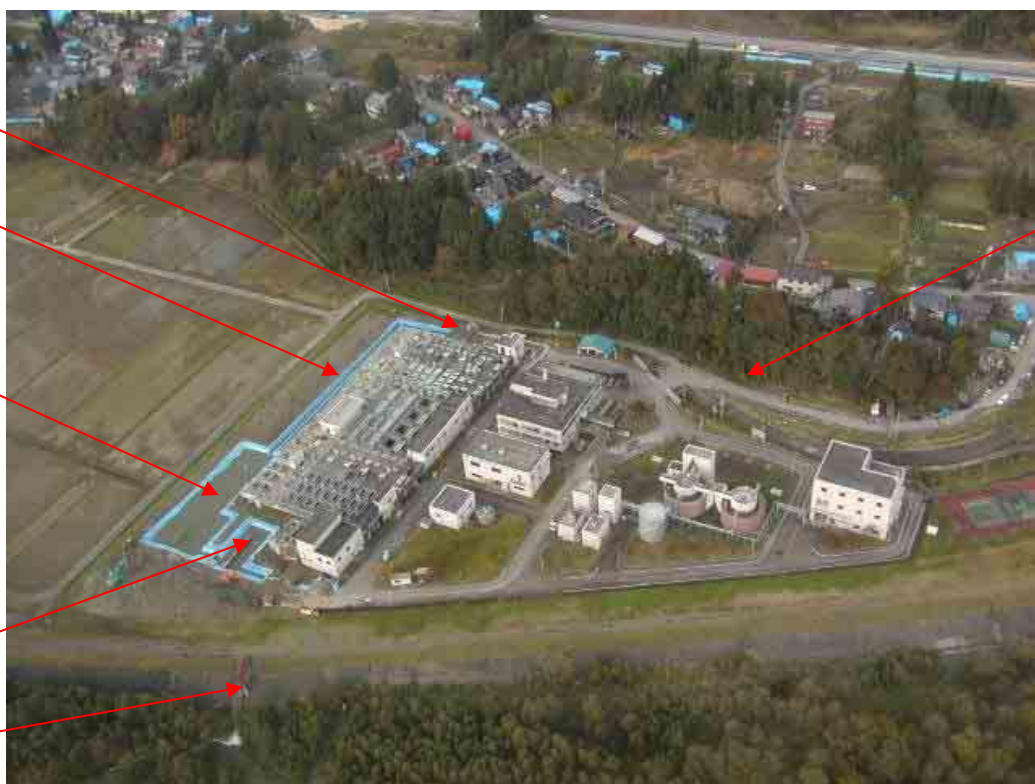
写真 9 応急復旧状況
