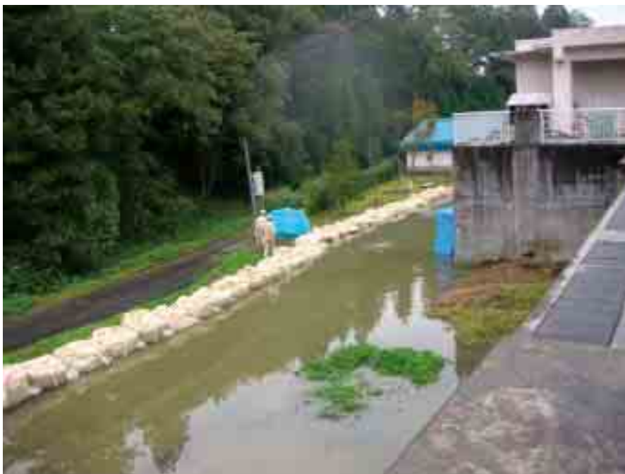
写真 - 2 土嚢を設置した状況
