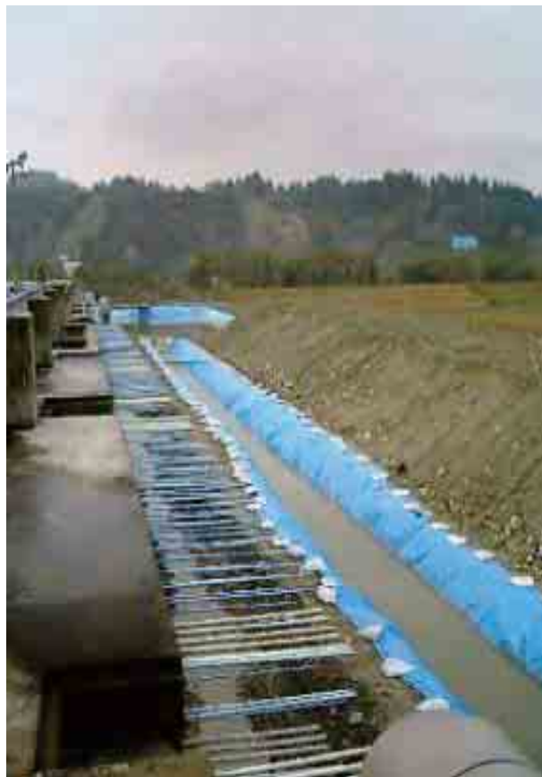
写真 - 12 仮設水路 ( )
