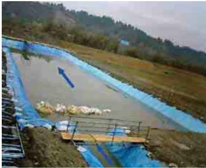
写真 - 1 3 仮設沈殿池 ( )
