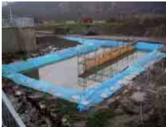
写真 - 1 4 仮設塩素混和池 ( )
