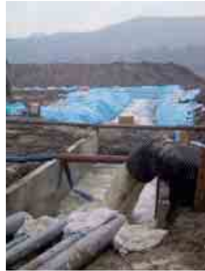
写真 11 仮設管からの流入状況 ( )
