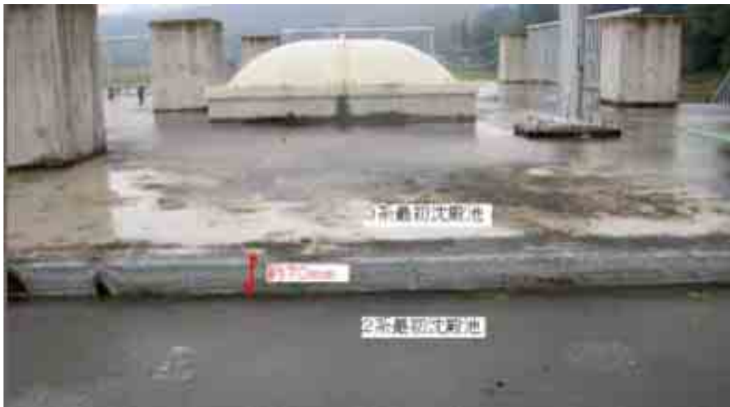
写真 - 4 最初沈殿地の段差
