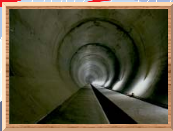
〇〇雨水幹線の中
