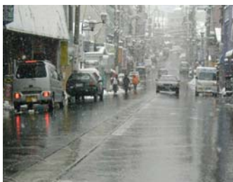
下水処理水を活用した消雪
