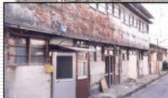
老朽木造アパート
