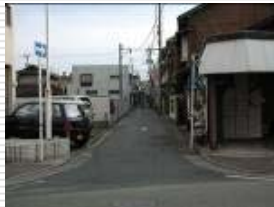
狭隘な区画道路
