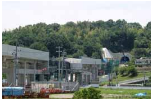
けいはんな線白庭高架橋工事
