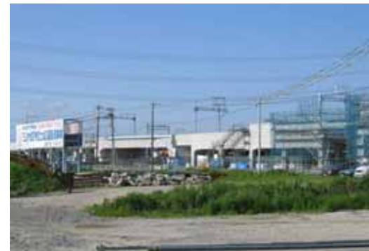
近鉄三山木駅付近高架工事(H17年秋完成予定)
