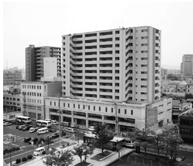
完成した南殿町再開発ビル
