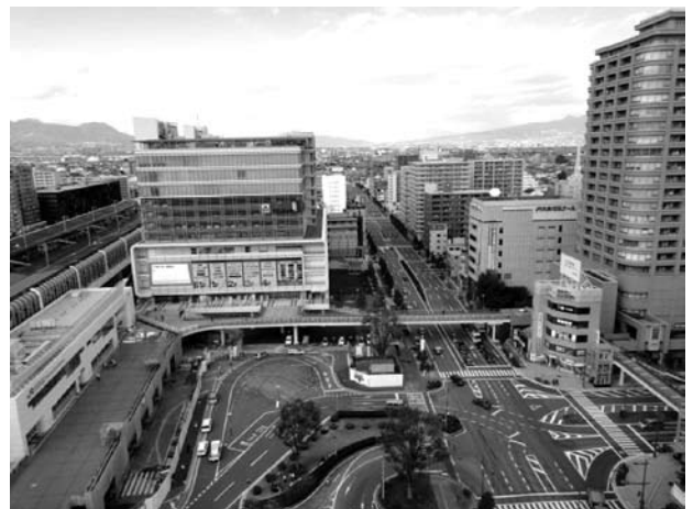
高崎駅東口ペDESTリアンデッキ
