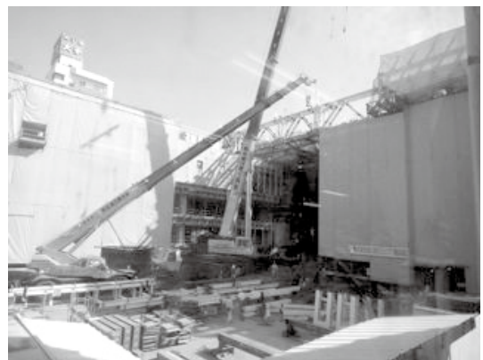
(シティホールプラザ「アオーレ長岡」の建設現場風景)
