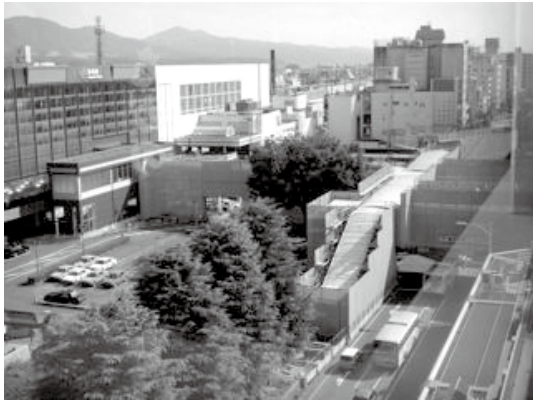
(駅前広場整備・ペDESTリアンデッキ建設風景)
