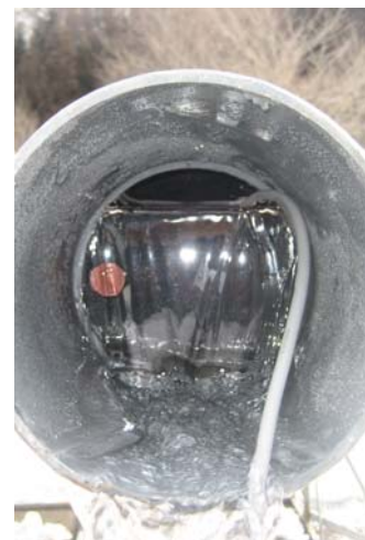
写真-2 堰部の流水状況（ケース 4）
