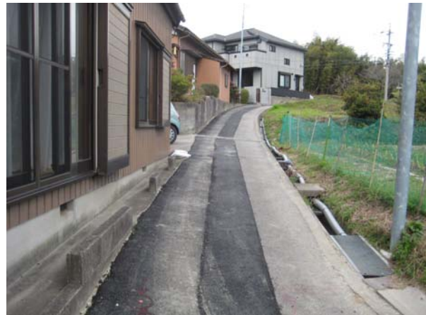
写真－1 狭小道路
