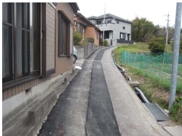
写真－1 狭小道路
