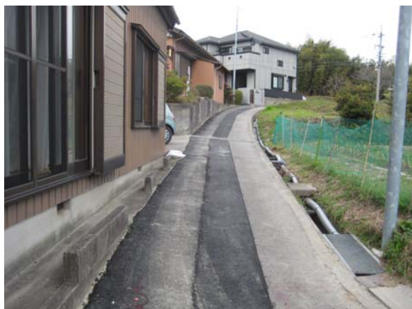
写真－1 狭小道路
