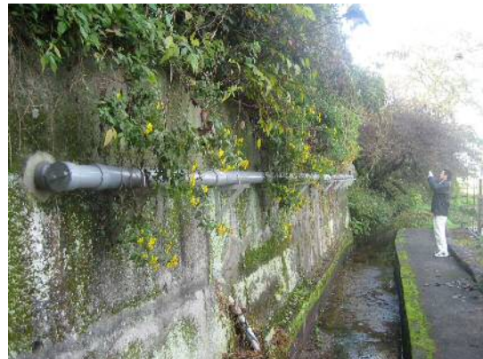
写真-1 クイック配管（露出配管）
