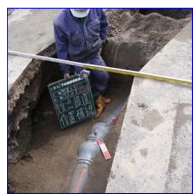
道路線形に合わせた施工(岡崎市)
