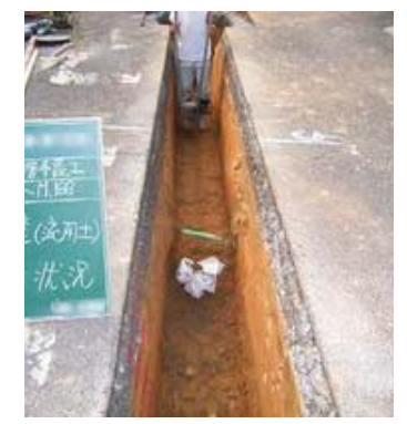
発生土の管きょ基礎への利用(半田市)
