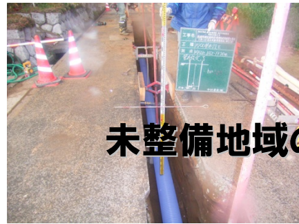
流動化処理土の管きょ施工への利用
