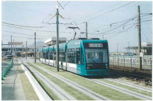
図4 - 59 . 樹脂固定軌道 同時に芝生軌道化した例 出典：広島電鉄資料
