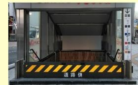
出入口への止水板設置
