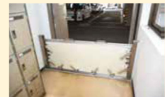
止水板の設置例
