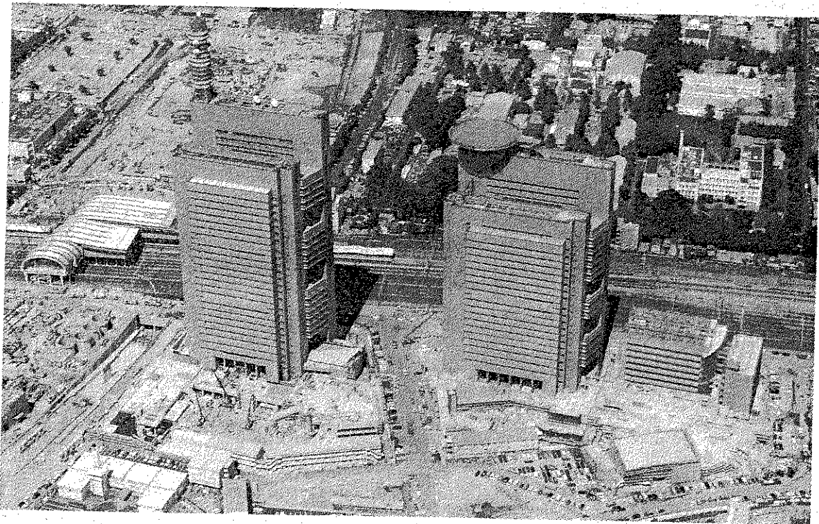
さいたま新都心シビックコア地区の中核施設となる さいたま広域合同庁舎
